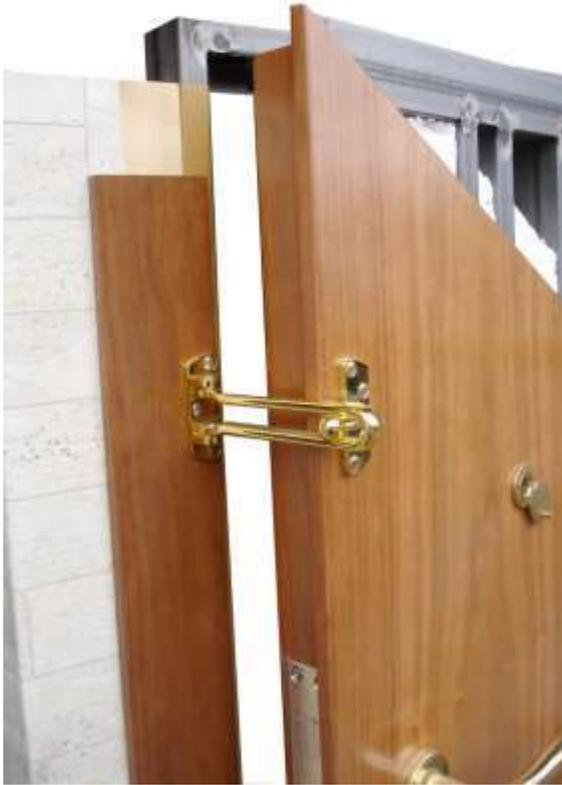
Limitador de apertura de seguridad. Sus dos partes se atornillan a la hoja y marco de acero, lo que le permite abrir parcialmente la puerta con total seguridad cuando reciba alguna visita dudosa, evitando un posible intento de irrumpir en la entrada.
